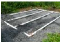
Les dimensions, la conception et la disposition de l'élément épurateur sont fondées sur le volume d'eaux usées produites, le nombre de chambres à coucher, la capacité d'absorption des sols sous-jacents ou la distance par rapport au niveau supérieur de la nappe phréatique.
