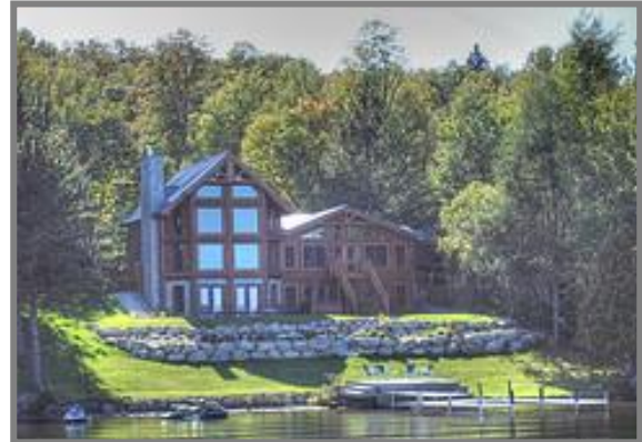
RIVE NON CONFORME
