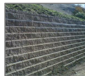
MUR DE SOUTÈNEMENT
