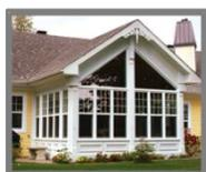
Pièce contiguë au bâtiment principal et considérée comme en faisant partie, comprenant un maximum de 20 % d'ouverture sans système de chauffage, non utilisé l'hiver et séparé du bâtiment principal par un mur plein, avec ou sans porte (permis d'agrandissement nécessaire).
