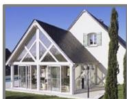
Bâtiment ou partie d'un bâtiment, composé à 80 % de grandes surfaces vitrées. Les verrières sont chauffées et conçues pour être utilisées tout au long de l'année. La superficie de plancher de cette construction, faisant partie du bâtiment principal, est prise en compte dans la superficie du bâtiment. (Permis d'agrandissement nécessaire).
