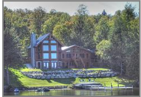
RIVE NON CONFORME
